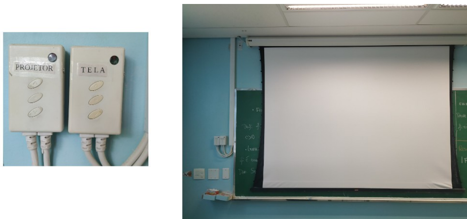
Figura 3: tela elétrica e os controles de acionamento da tela e do lift
