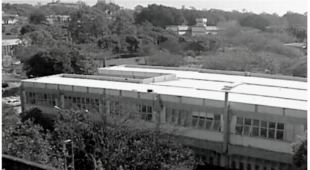
A foto panorâmica mostra toda a extensão do telhado novo reformado no Bloco B
